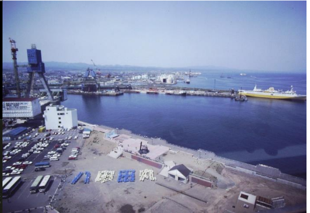
工事中の青森ベイブリッジと八甲田丸 平成 2 年 5 月
